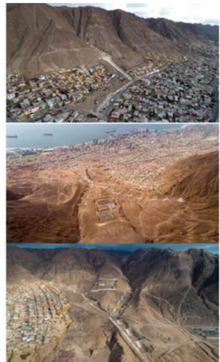
Figura 43 Obras de control aluvional
